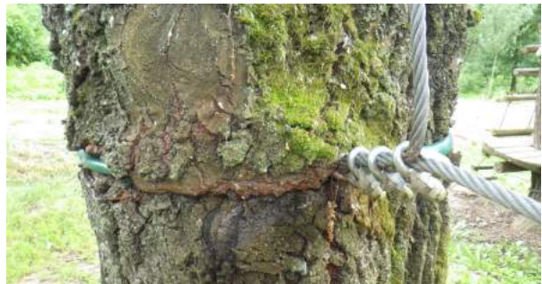
Karbantartás mellőzése miatt a fa körbe nőtt a sodronykötél
